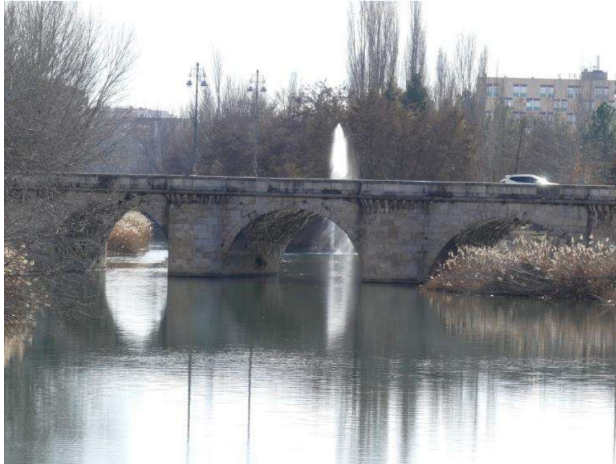
Ilustración 35: Río Carrión en el entorno de Puenteillas a su paso por Palencia. Fuente: Elaboración propia.
