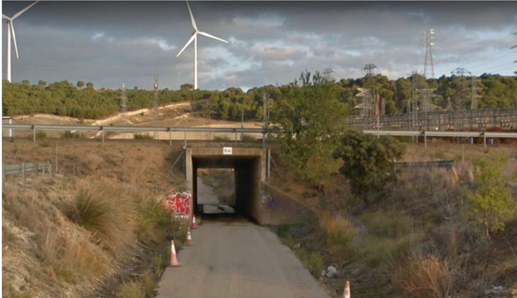
Ilustración 39: Paso bajo la A-67 en el camino a Magaz. Fuente: Google Maps.
