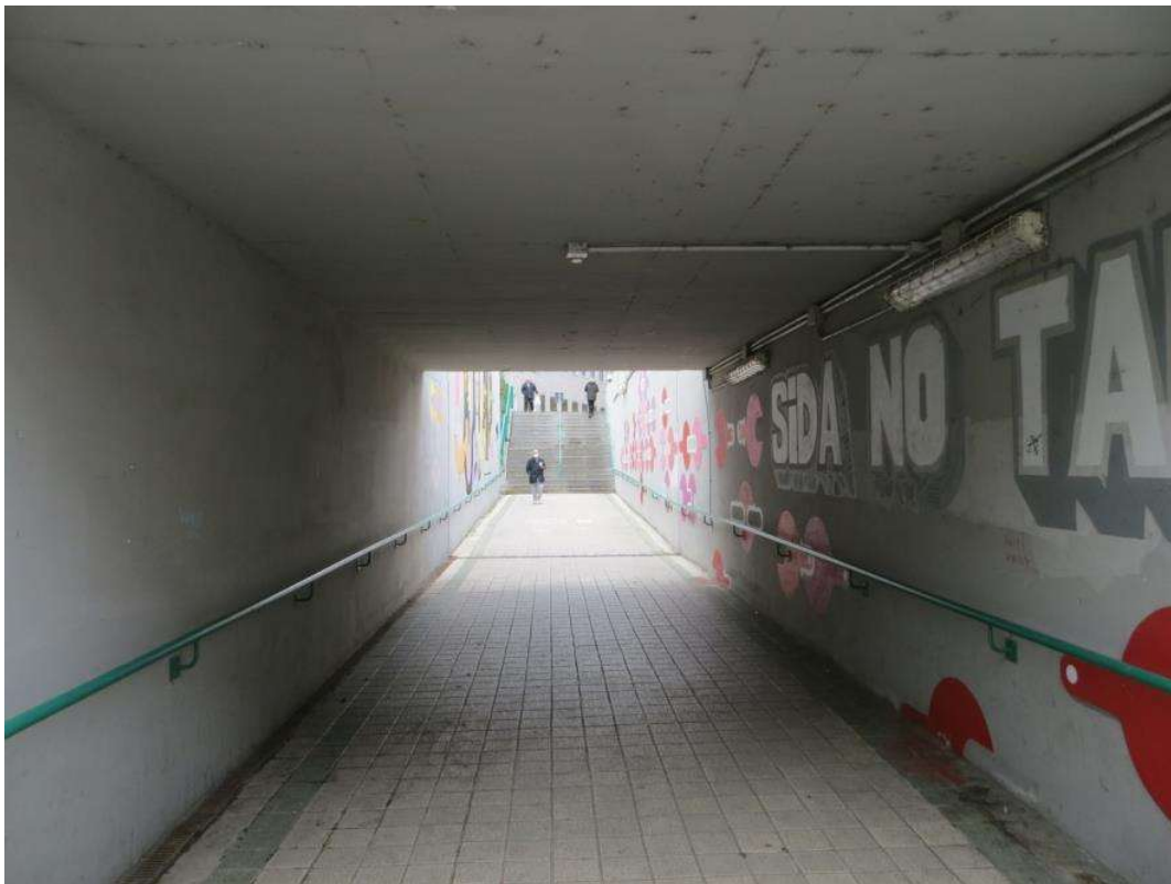
Ilustración 41: Paso subterráneo del ferrocarril hacia plaza Pintor Caneja. Fuente: Elaboración propia.
