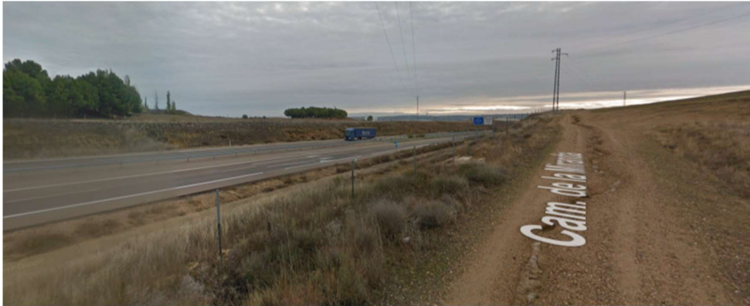
Ilustración 37: Vista de la A-65 desde el camino de la Miranda. Fuente: Google Maps.
