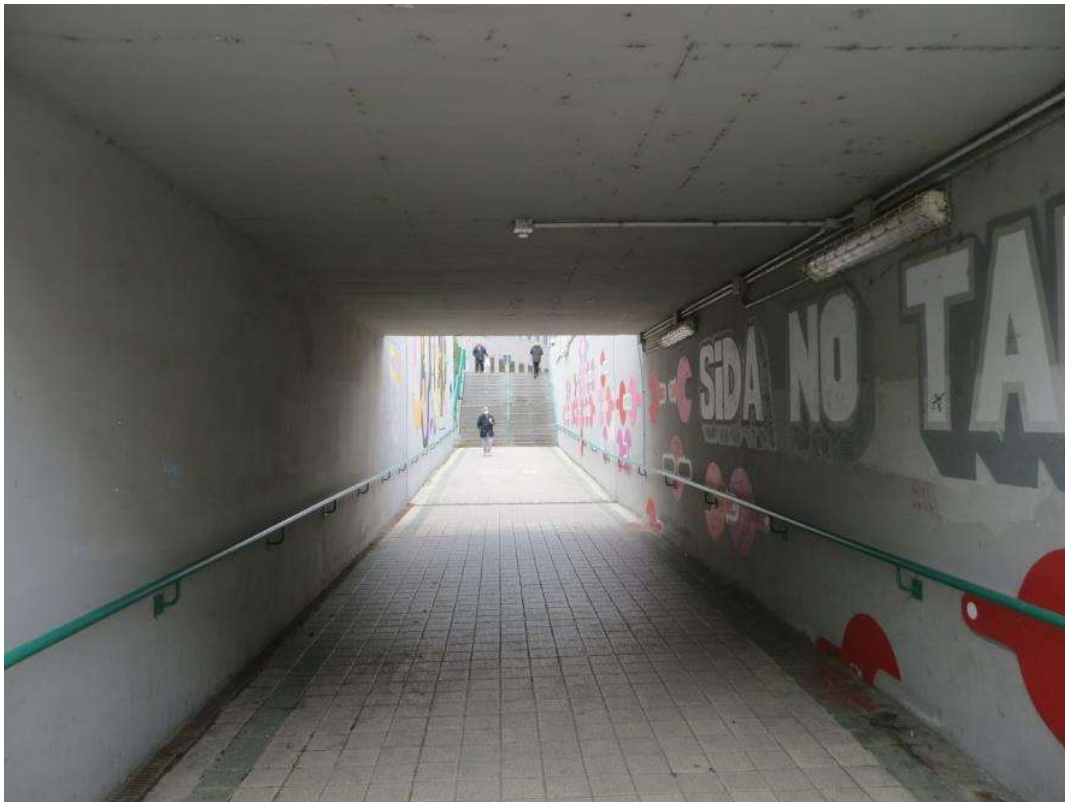
Ilustración 71: Paso subterráneo del ferrocarril hacia plaza Pintor Caneja. Fuente: Elaboración propia.
