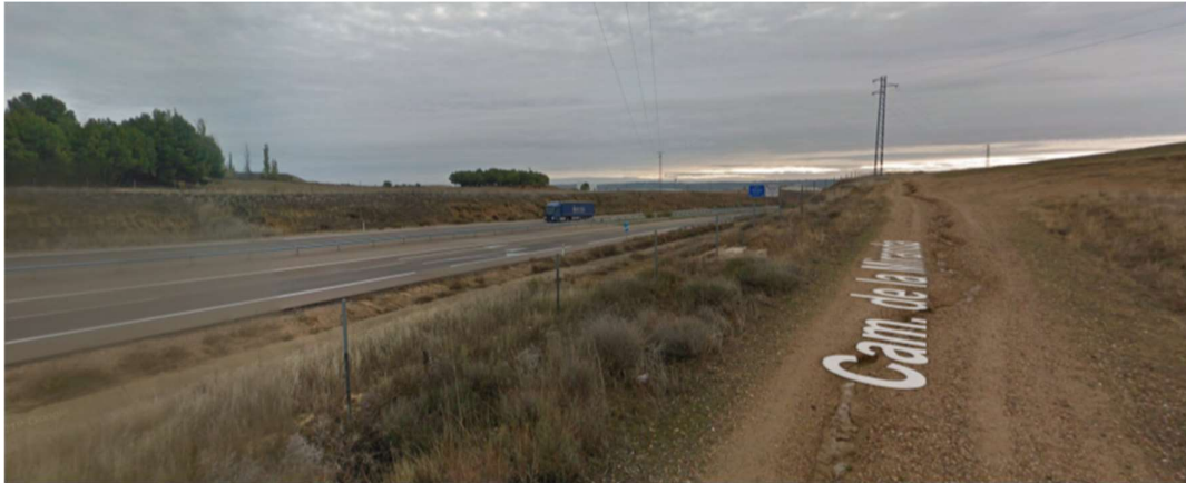
Ilustración 67: Vista de la A-65 desde el camino de la Miranda. Fuente: Google Maps.
