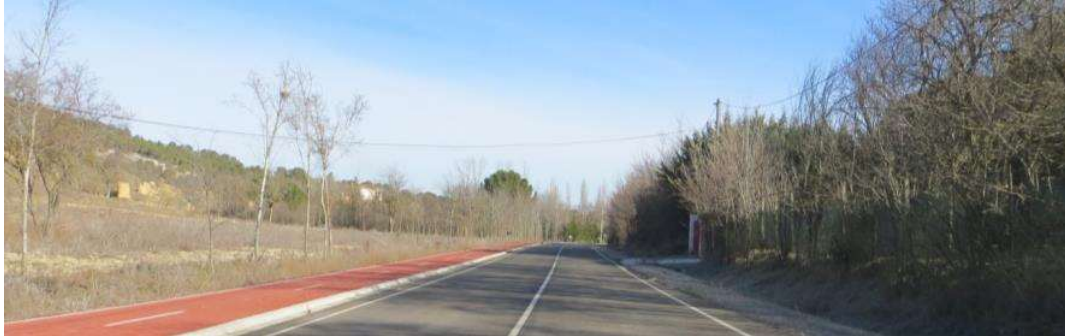
Ilustración 25. Carretera de acceso PP-9901 al Monte El Viejo. Fuente: Elaboración propia.
