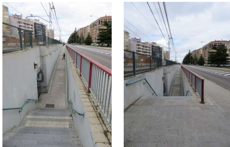
Ilustración 61. Paso subterráneo del ferrocarril. Fuente: Elaboración propia.
