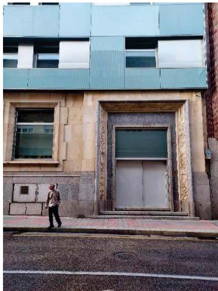
Estado actual del edificio
