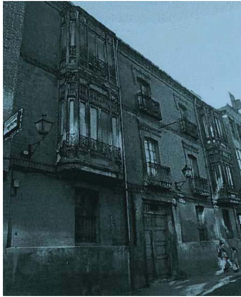
Antigua fachada del edificio derribado
