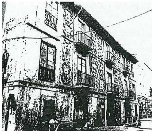
Antigua fachada del edificio derribado
