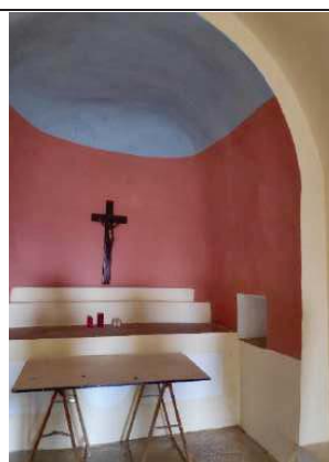
Capilla semicircular horadada en el cerro. bóveda de cuarto de esfera.
