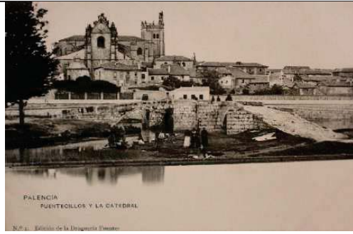
Fotografía de finales del siglo XIX, aún no se había construido el convento de las HH de los Ancianos desamparados. Colección Fuentes. Pretil deteriorado y afloramiento de las piedras de la bóveda en el tramo oeste, ribera derecha del río.
