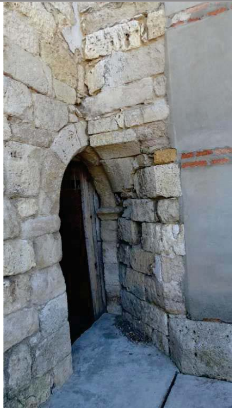
Vista exterior de la puerta de la torre, a la que se adosa el muro norte de la iglesia, cegando parte de la puerta de entrada.
