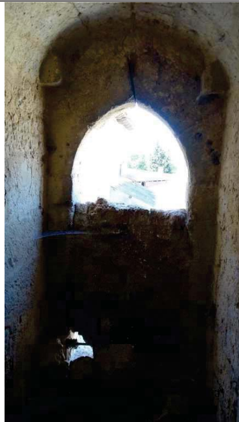
Vista Interior del vano ligeramente apuntado, con goznes de piedra para encajar una puerta.
