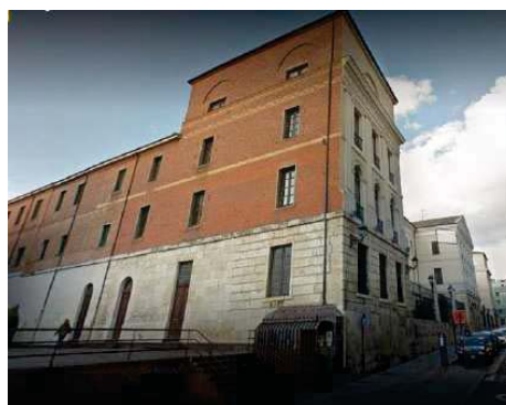
Fachada Oeste del Seminario Materiales de piedra sillar y ladrillo en la parte superior.
