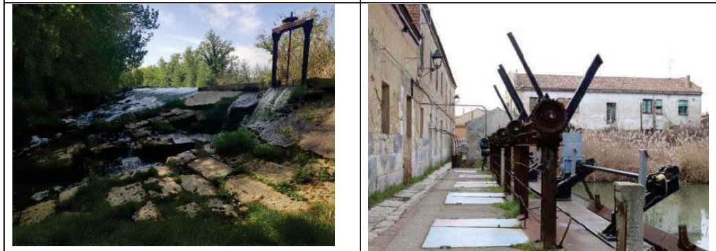
Parte antigua de la Pesquera del Sotillo, realizada con piedra caliza.
