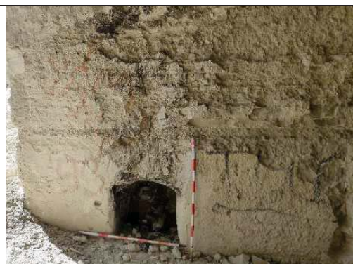
Detalle de la capilla oeste, fachada oeste con hornacina ciega y restos de hollín.
