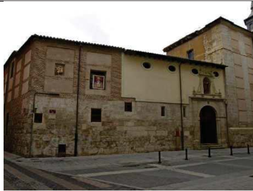
Exterior del convento Recoletas.
