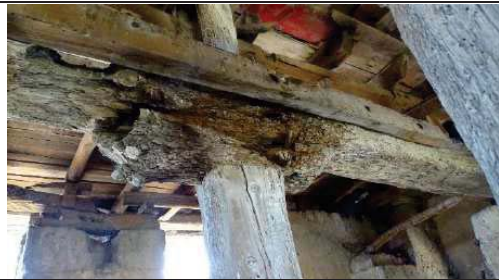
Interior con Techumbres de vigas de madera.
