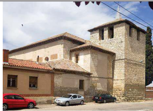
Vista actual de la cabecera de la iglesia y de la torre. En los años 60 se construyó la casa del cura, aneja a la sacristía.
