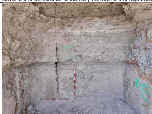
Capilla oeste, detalle pequeño resalte o banco de apoyo. Techumbre derruida. Su estado de conservación es muy malo, existen numerosas grietas verticales. En la parte superior se observa como se ha desprendido el techo original. La estancia estuvo enyesada y encalada, se observa estos detalle en la estratigrafía muraria de las paredes y restos del techo.
