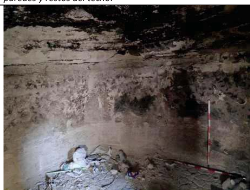
Capilla oeste, detalle pequeño resalte o banco de apoyo. Techumbre derruida. Su estado de conservación es muy malo, existen numerosas grietas verticales. En la parte superior se observa como se ha desprendido el techo original. La estancia estuvo enyesada y encalada, se observa estos detalle en la estratigrafía muraria de las paredes y restos del techo.
