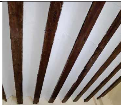
Artesonado de vigas de madera unidas con bovedilla de yeso. Detalle
