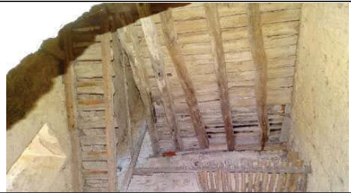
Interior del vestusto cubo, totalmente libre de estructuras interiores. A él se adapta una escalera de madera con escasa planificación, pegada a las muros que da acceso a la parte superior.
