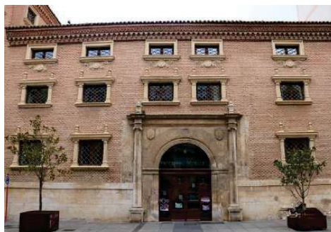
Convento rehabilitado en los años 80 como dependencias administrativas del Ayuntamiento.
