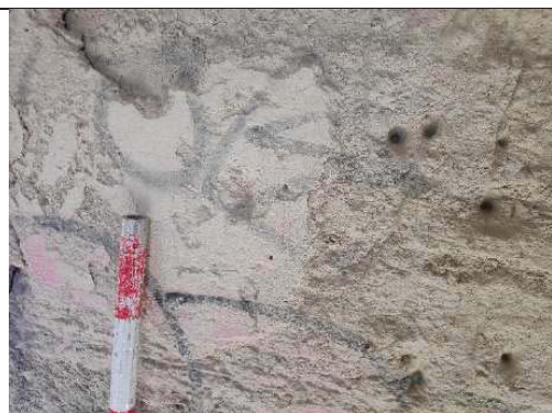
Laguna con revoque de yeso y cal de unos 2 cm de grosor que enlucia paredes y techos, se conservan muy pocos restos.
