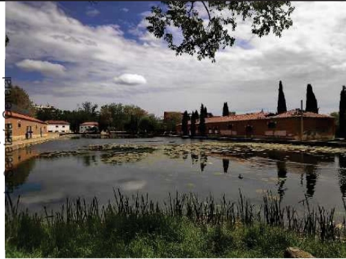
Vista general del ámbito del canal que se encuentra dentro de la delimitación del BIC. Dársena y sus edificios, desde el oeste.
