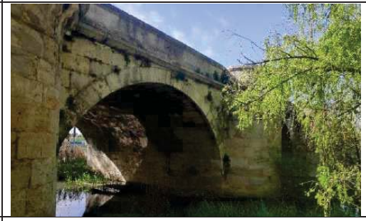
Detalle de las características constructivas del puente, arco de la margen izquierda en su lateral norte.
