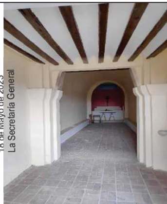
Zaguán de entrada cubierto por un artesonado de vigas de madera unidas con bovedilla de yeso
