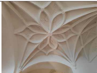
Capilla situada en el lateral suroccidental de la nave de la Epistola, detalle de la bóveda de crucería.
