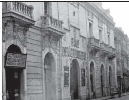
Detalle, de la portada de arco de medio punto con blasones Y decoracion de guirnaldas en ventanas superiores y ménsulas en las arcadas inferiores.
