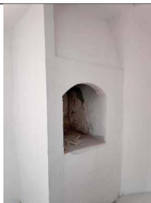
Horno y chimenea habilitado en la planta superior.
