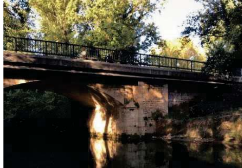
Actual Puente de Sandoval. Estructura de Piedra sillar, cubierta por un tablero de hormigón y pretil de hierro contemporáneos.
