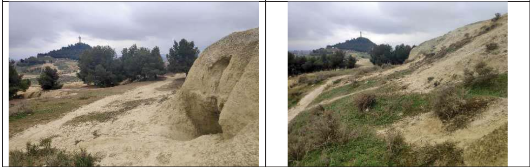
Coord. 30 T 373478 4654629 Casa cueva -3- Puerta de acceso más estrecha a semejanza de una galería, en mal estado. Ámbito exterior de las casas-cueva.
