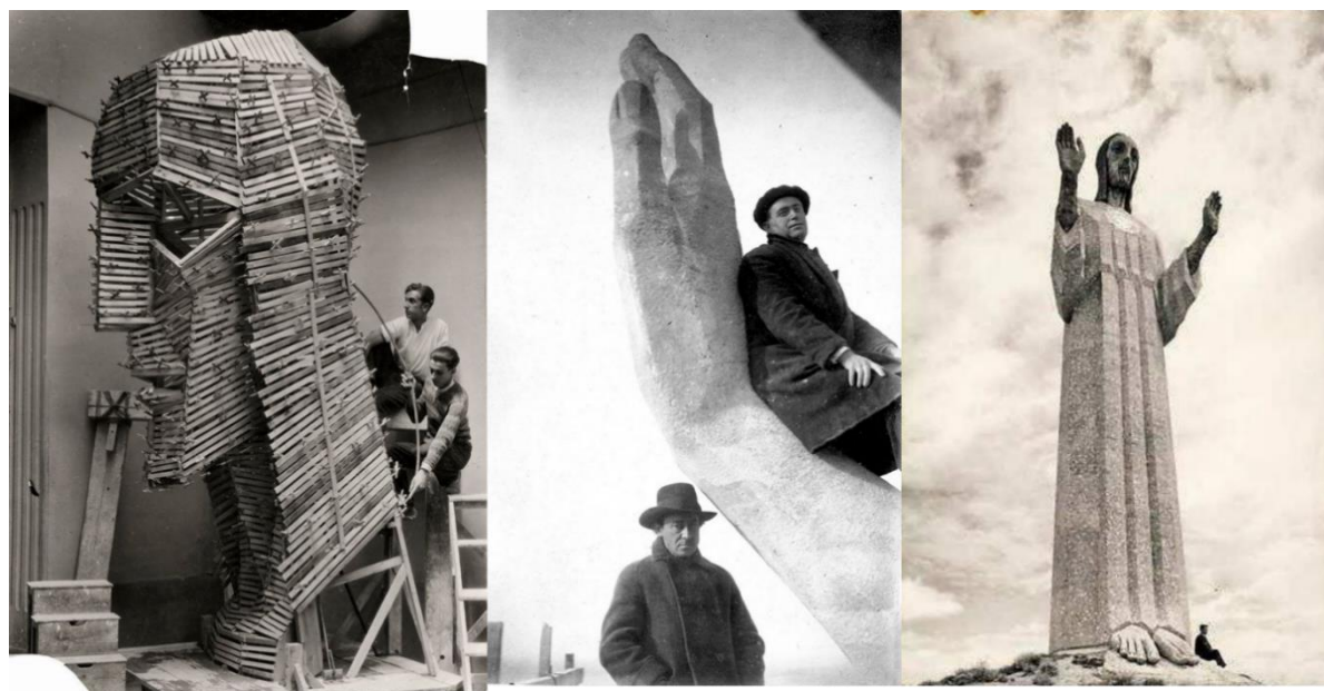
Figura 9.- La estructura base del Cristo del Otero, será construida en
