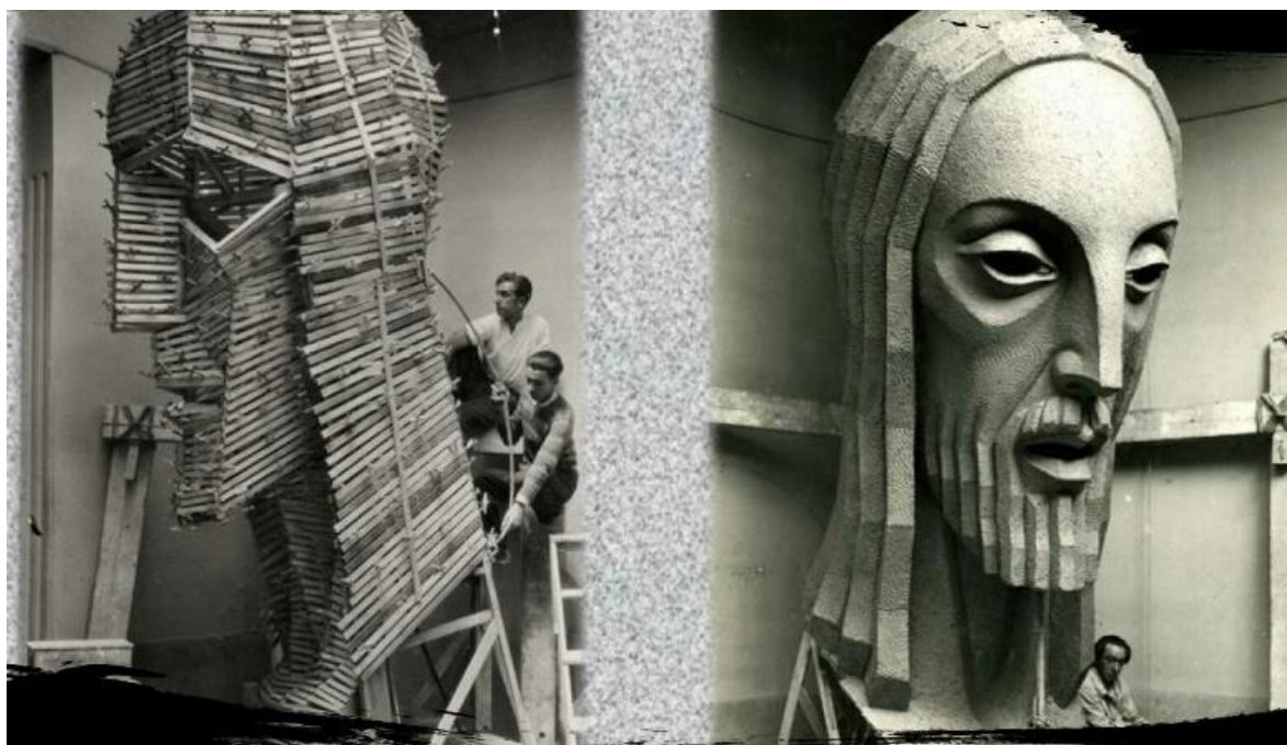
Ilustración 37.- Diversas técnicas fueron utilizadas como el vaciado o las cimbras de madera, andamios y placas de piedra preformadas.
