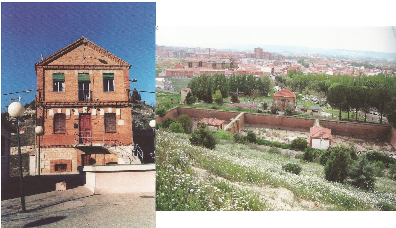
Figura 6. Casa de llaves y vasos de ladrillos y hormigón para la decantación de las aguas en el Otero. Obra del arquitecto Jerónimo Arroyo. 1908.
