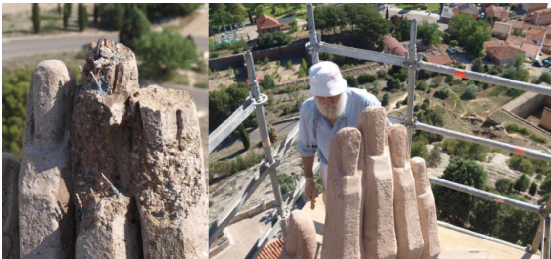
Figura 2.- Trabajos de restauración volumétrica de manos, cabeza y pies del Cristo del Otero realizados entre 2015 y 2016 a Valuarte Conservación del Patrimonio.
