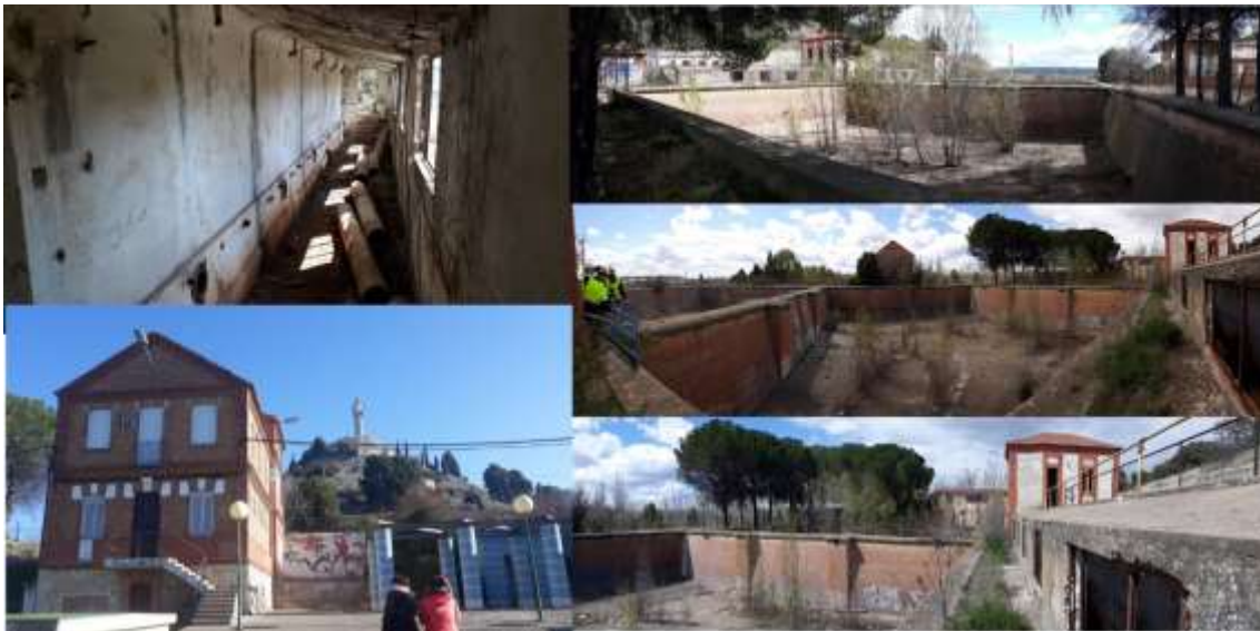
Figura 9. Depósito sur y edificaciones auxiliares, contemporáneas del mismo, cuya restauración, reforma y rehabilitación están previstas en el Plan Director.
