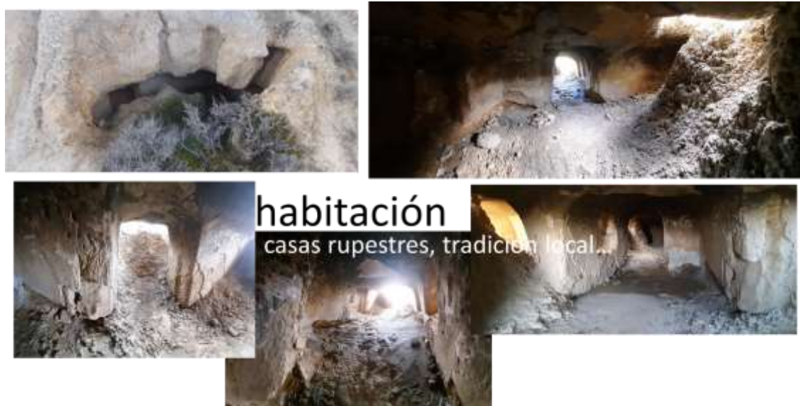
Figura 25. Casa rupestre a media ladera, ce02, vistas del interior. Fotografías: Antonio Hoyuela. Así ocurrió en el primer frente, el Cerro del Otero, con las ermitas de Santo Toribio y Santa María. O bien permanecieron como ermitas rupestres, como ocurre en el Cerro de San Juanillo, en un área más alejada y despoblada, con algunas piezas funcionando como capillas, con sus hornacinas, altares, y diferentes salas dedicadas a la oración, a la habitación, o incluso a la meditación, descanso o almacenaje. Es por eso por lo que algunas salas tienen ventilación natural, y otras se encuentran completamente encajadas en el interior de la montaña, accediéndose a ellas tan solo por pequeñas puertas en el interior de la gruta.
