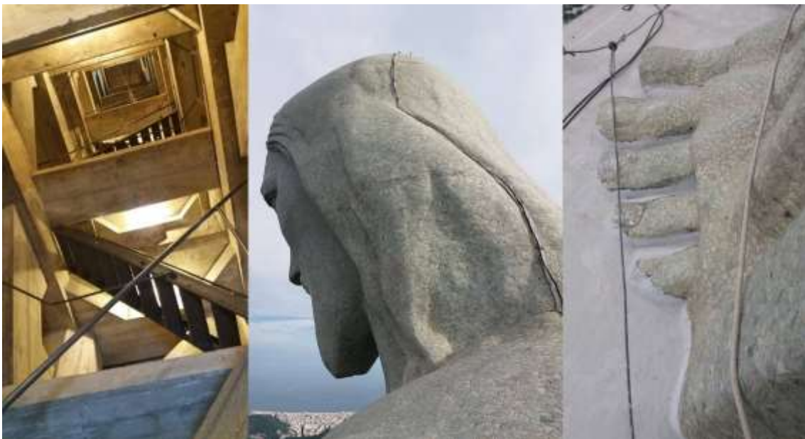
Ilustración 3 .- Imágenes del Cristo Redentor, de Rio de Janeiro: escaleras y estructura interior, cabeza y pies de la gran escultura. Fotografías: Antonio Hoyuela Jayo.
