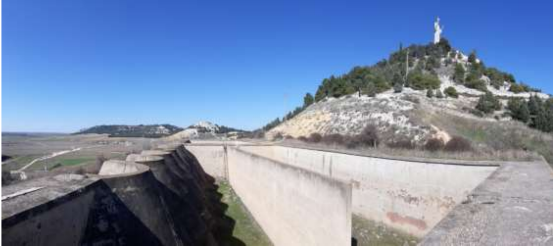
Figura 54. A finales de los años 40 el ayuntamiento completa el conjunto iniciando la construcción de un depósito de decantación en hormigón armado, una interesante estructura "racionalista", con bóvedas inclinadas del lado de la ciudad, que nunca llegó a ponerse en operación, pero que nos dejó un contenedor de interés para nuestra propuesta. Fuente: fotografía de Antonio Hoyuela, con ambos cerros (Otero, en primer plano, y San Juanillo, en segundo).
