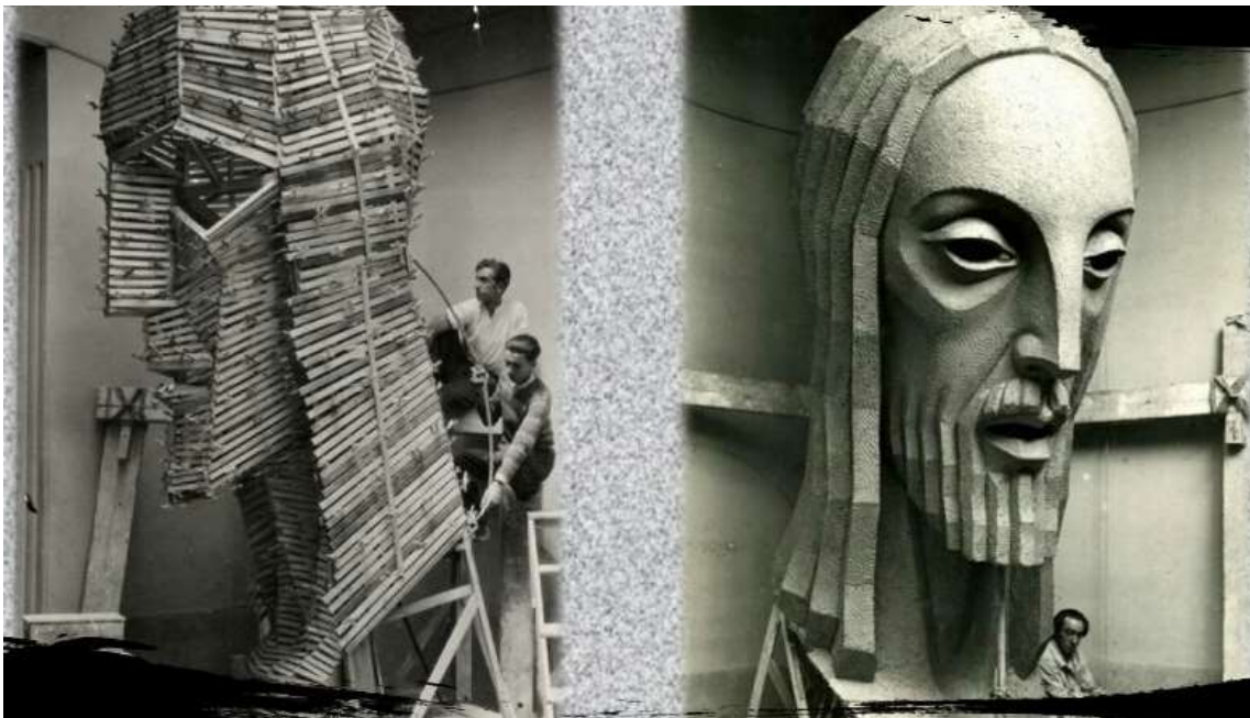
Figura 42.- Diversas técnicas (encofrado perdido, vaciado y bases de tablas y estructuras de madera) fueron utilizadas como el vaciado o las cimbras de madera, andamios y placas de piedra preformadas.
