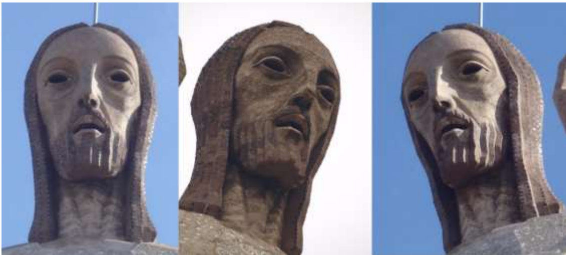
Figura 46. Cabeza hueca. En el centro, antes de la restauración, y en los laterales, después de la restauración donde observamos la recuperación de las áreas degradadas y la limpieza. Foto: Valuarte, 2017 © Valuarte
