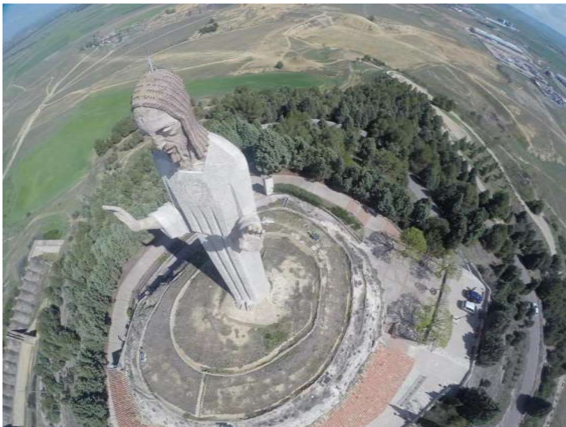
Figura 38. Conjunto del Cristo del Otero y de las instalaciones de iluminación, basamento, y acceso final al monumento. Fotografía © de Valuarte, 2017
