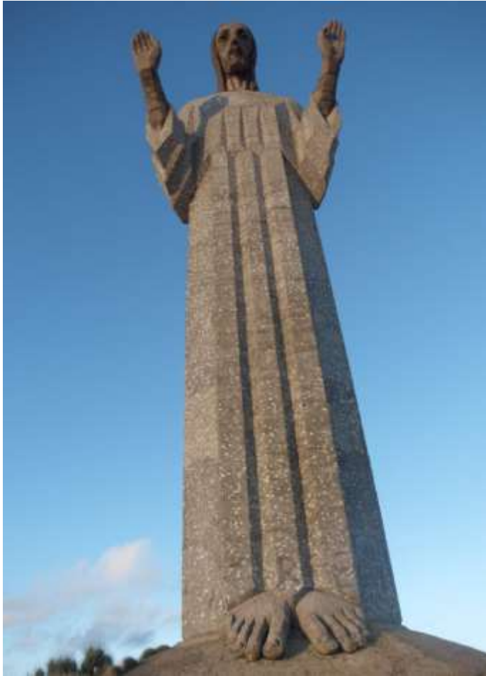
Figura 40. Vista del Cristo durante las obras de restauración del equipo de Valuarte, fuente: Valuarte.
