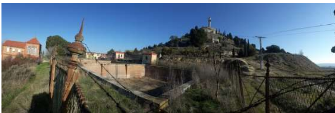
Figura 13. El depósito sur dialoga con el cerro y con el Cristo del Otero, siendo que desde su extremo sureste la vista del conjunto permite, de una sola vez, observar el depósito, las ermitas de Santo Toribio, y Santa María, las edificaciones auxiliares, e incluso una parte del depósito de decantación.
