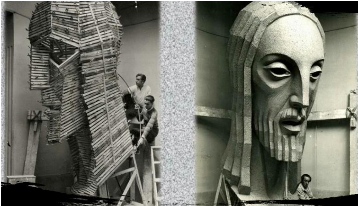
Figura 6.- Diversas técnicas fueron utilizadas como el vaciado o las cimbras de madera, andamios y placas de piedra prefabricadas.
