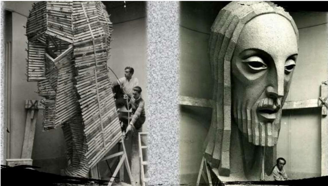
*Figura 166.- Diversas técnicas (encofrado perdido, vaciado y bases de tablas y estructuras de madera) fueron utilizadas como el vaciado o las cimbras de madera, andamios y placas de piedra preformadas.*
