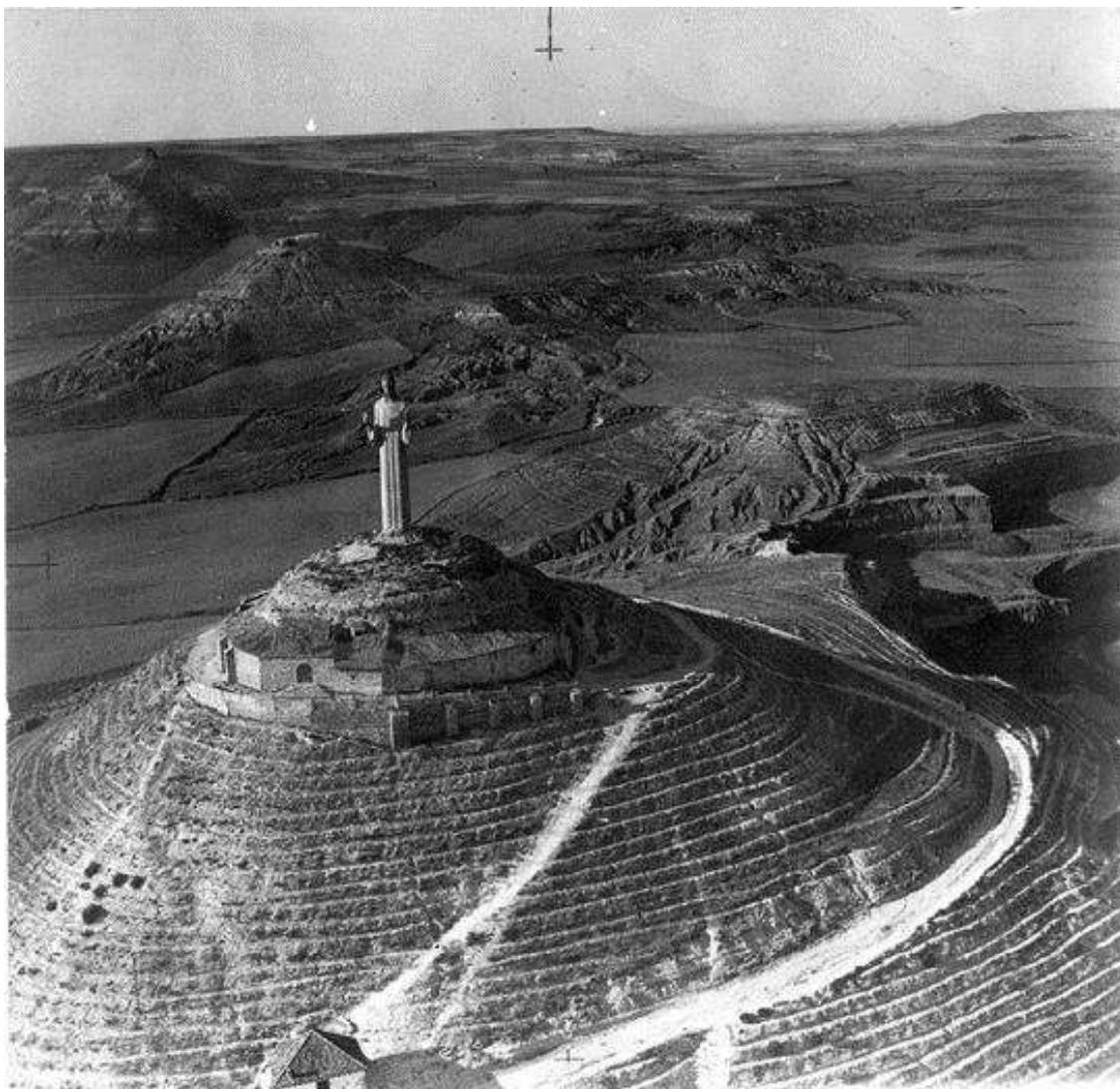
*Figura 71. La colina del Cerro del Otero sin vegetación, con apenas un camino de tierra y bancales para la retención del agua de lluvia antes de la construcción del cinturón de hormigón armado.*
