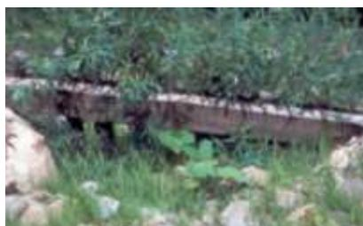
**Descripción y aplicación:** Como obra transversal viva en zanjas que no siempre llevan agua o escalón del terreno en suelos sueltos de loess, barro o limo. Se clavan las estacas vivas una a lado de la otra, construyendo una fila a una distancia entre ellas del mismo tamaño que el diámetro de las estacas. Cada una de las estacas, tiene que estar introducida en el suelo, por lo menos, a un tercio de su longitud. Las estacas se unen, por uno o por los dos lados, con piquetas transversales.
