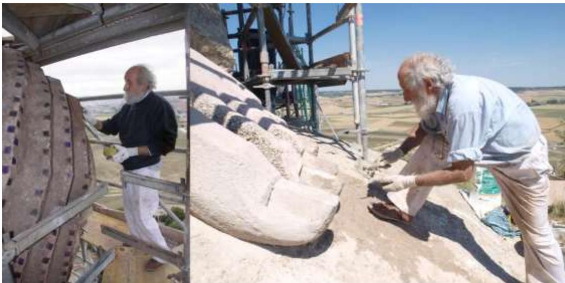
*Figura 109. En las fotografías podemos observar a Luis Alonso trabajando a los pies del Cristo del Otero, y los trabajos de retoque, corrección y restauración de los acabados del hormigón, y los andamios que fueron instalados, durante de las obras de restauración de 2015, de la empresa Valuarte Conservación del Patrimonio. © Fotos de su informe publicado en 2017.*
