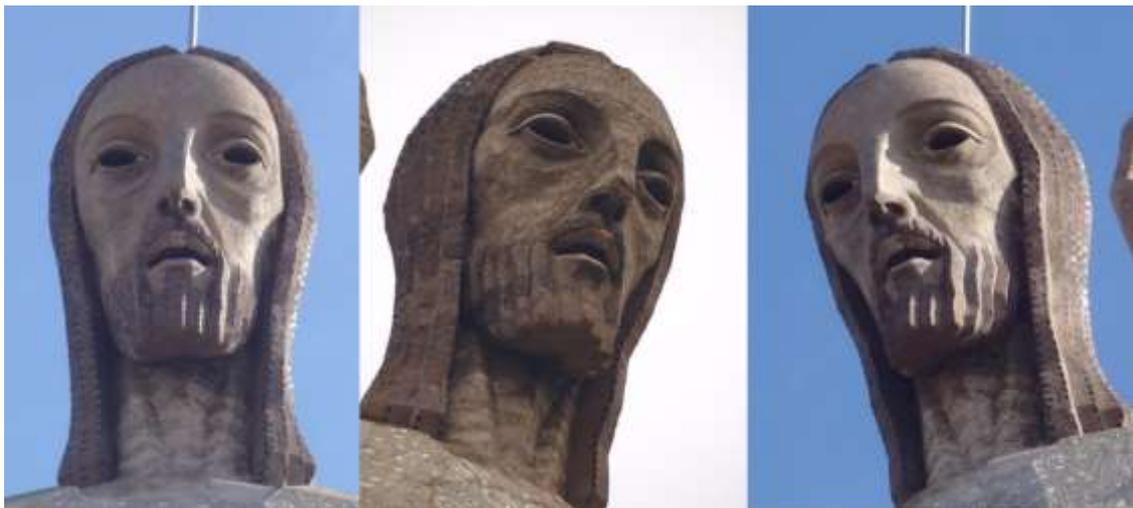
*Figura 170. Cabeza hueca. En el centro, antes de la restauración, y en los laterales, después de la restauración donde observamos la recuperación de las áreas degradadas y la limpieza. Foto: Valuarte, 2017 © Valuarte*
