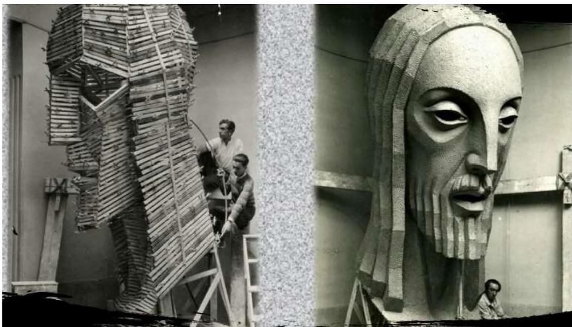
*Figura 17. Diversas técnicas fueron utilizadas como el vaciado o las cimbras de madera, andamios y placas de piedra prefabricadas.*
