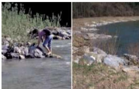
**Descripción y aplicación:** Protección de riberas en cauces fluviales. Se construyen deflectores con piedras de escollera pesadas, adicionalmente se aseguran con posters o piquetas. Los deflectores se instalan inclinados, a la izquierda o derecha o perpendiculares a la orilla, en una línea descendente desde la orilla hasta el lecho (1-15m de longitud). Durante la construcción o posteriormente, se introducen estacas o ramas vivas en los intersticios y se rellenan con suelo fértil.
