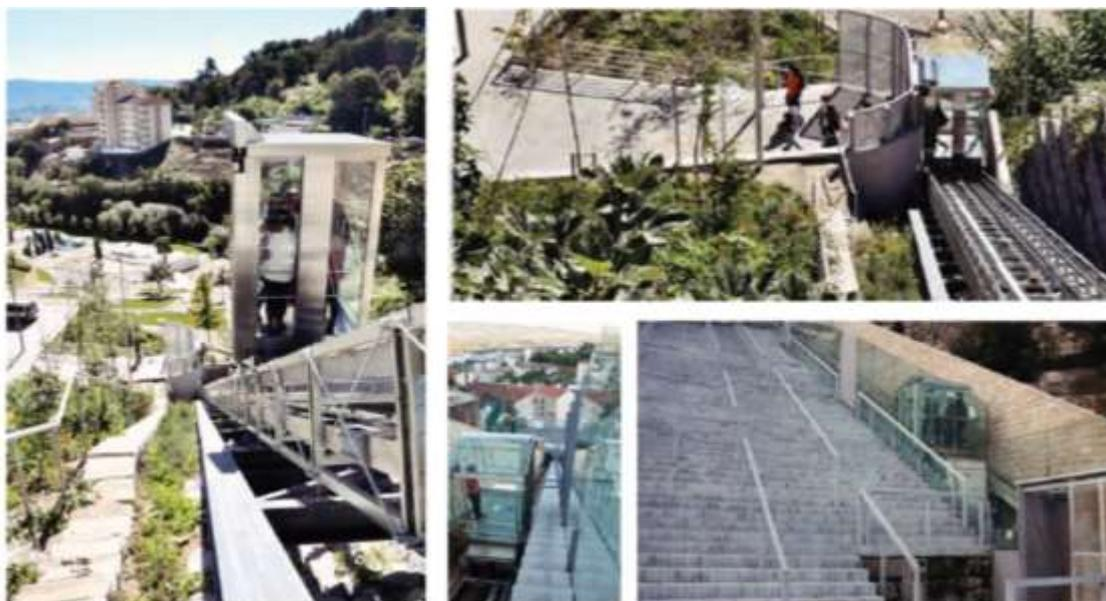
Figura 239. Fueron consideradas las tres alternativas siendo que la del teleférico o telecabina fue descartada por su fuerte impacto visual, el túnel por cuestiones de seguridad de la gran superficie a ser soterrada (en obra y en funcionamiento) y la solución del elevador inclinado se mostró como la más barata para ese tipo de situación. Foto: LIFTECH, instalación Parque da Goldra, PT.
