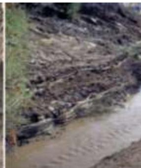
**Descripción y aplicación:** Estabilización de pendientes, mantenimiento capa superior de suelo y reforzamiento de la orilla. Primero se clavan estacas o piquetas en el suelo a una distancia de 50 cm. Entre las estacas, se trenzan varas vivas que se introducen, al menos 20 cm, en su extremo más grueso en el suelo. Se rellenan los trenzados con tierra vegetal para que no se sequen.
